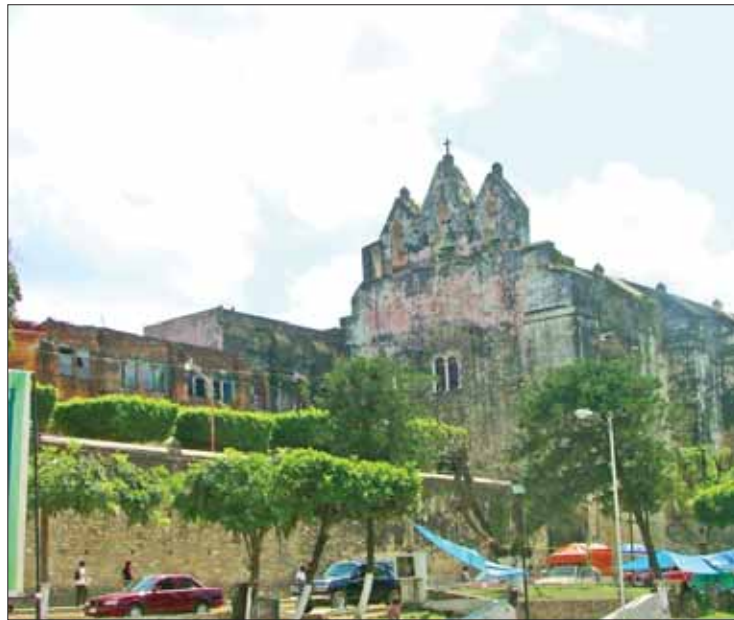
DETALLES. Ocurrió a las 3:25 horas de 7 de diciembre; sin ningún daño.
