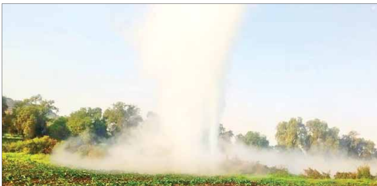
Fuente de más de 10 metros de altura se formó con la perforación de un ducto de Pemex, en zona donde apenas hubo explosión mortal.
