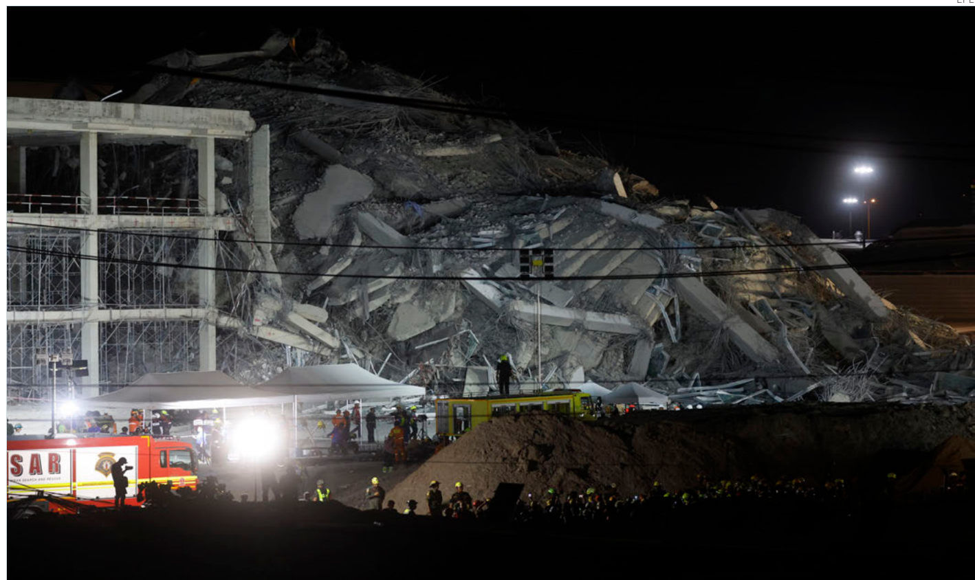
Vista de un edificio derrumbado después del terremoto que azotó Bangkok, Tailandia.
