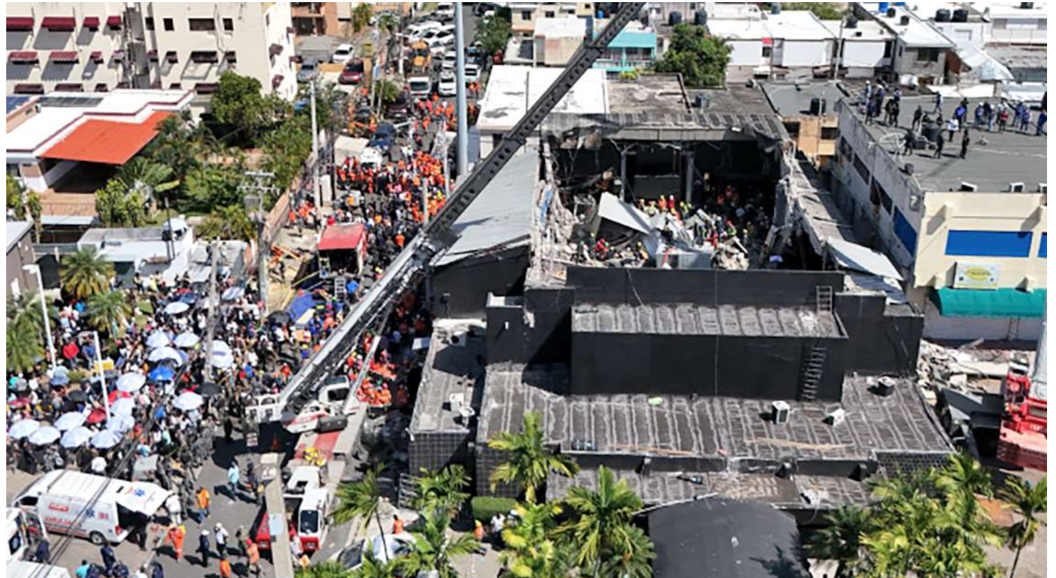
El techo de la discoteca Jet Set de Santo Domingo colapsó sobre centenares de personas.
