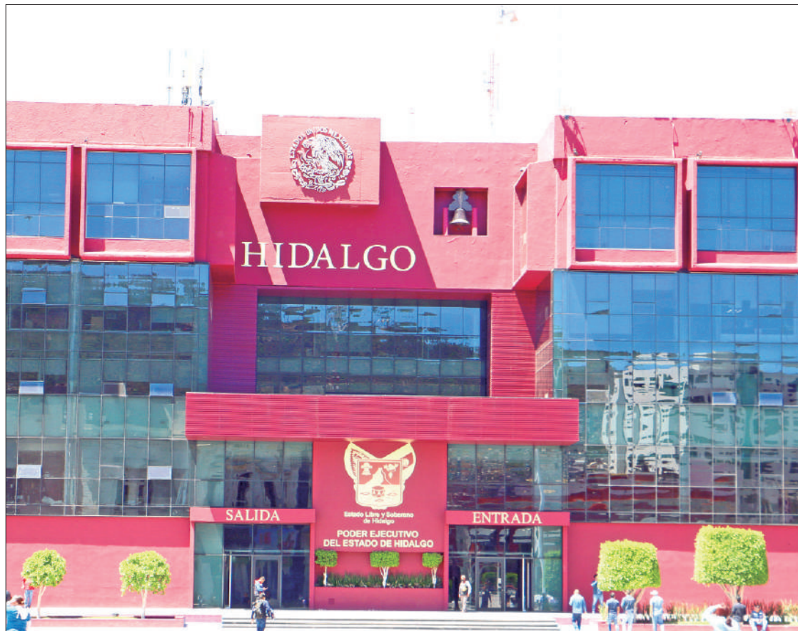
JMS. Ésta es una demostración de la indiferencia y la apatía que se dio en el transcurso del tiempo por parte de muchos o muchas funcionarias, y pensaron que simplemente trasladarlo a otra administración les resolvía el problema.
