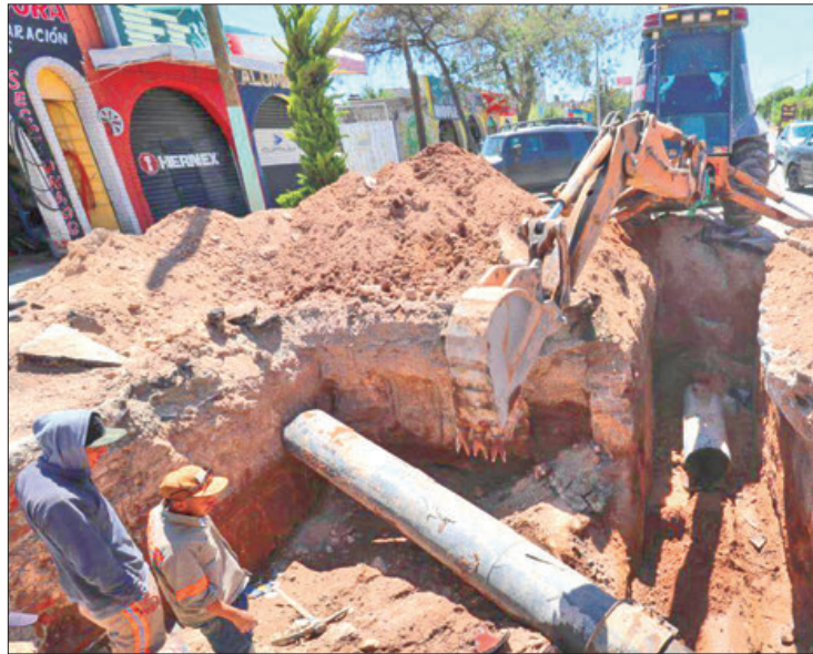
OPERATIVIDAD. La CAASIM lleva a cabo la corrección de los errores como el nivel de instalación de las tuberías y el ajuste de los niveles requeridos para su buen funcionamiento.
