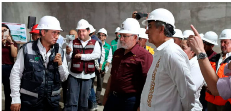
Américo Villarreal conoce a detalle avances de la obra carretera.
