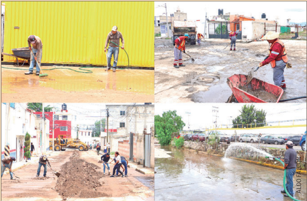
Afectaciones en al menos una decena de colonias de Pachuca y Mineral de la Reforma, a causa de las fuertes lluvias.
