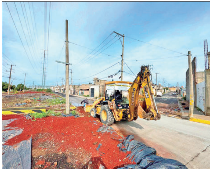
CORTÉS. Hasta la tarde de ayer, personal del municipio continuó con la limpieza del cárcamo de la zona sur de los fraccionamientos a la altura de Los Tuzos para evitar alguna contingencia.
