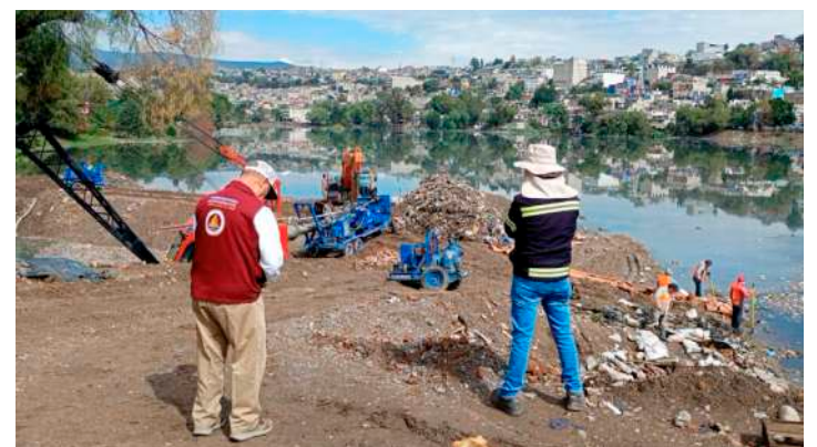
Debido a las fuertes lluvias se mantiene rigurosa vigilancia de la Presa Los Cuartos.
