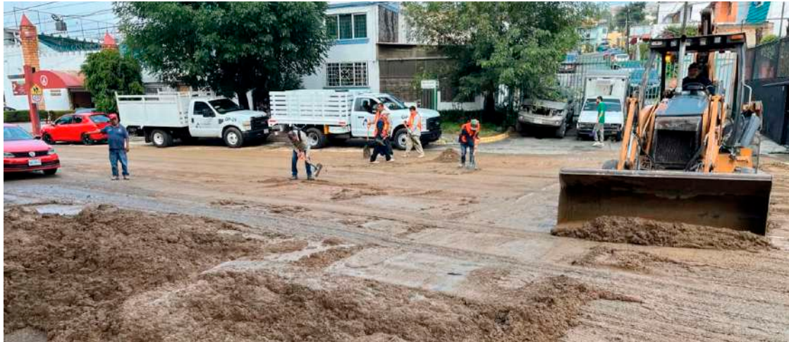
Labores de limpieza y retiro de lodo en la zona de Camino a Calacoaya.
