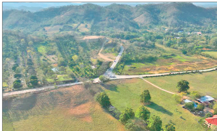
SICT. Estaremos de mayo a diciembre trabajando estos 30 kilómetros, y el próximo año estaremos ya concluyendo la totalidad de los 97 kilómetros que representa este tramo, explicó el secretario de Infraestructura, Jesús Antonio Esteva Medina, al supervisar los avances.
