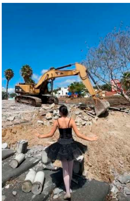
La demolición del espacio cultural en la ciudad de Tepic.
