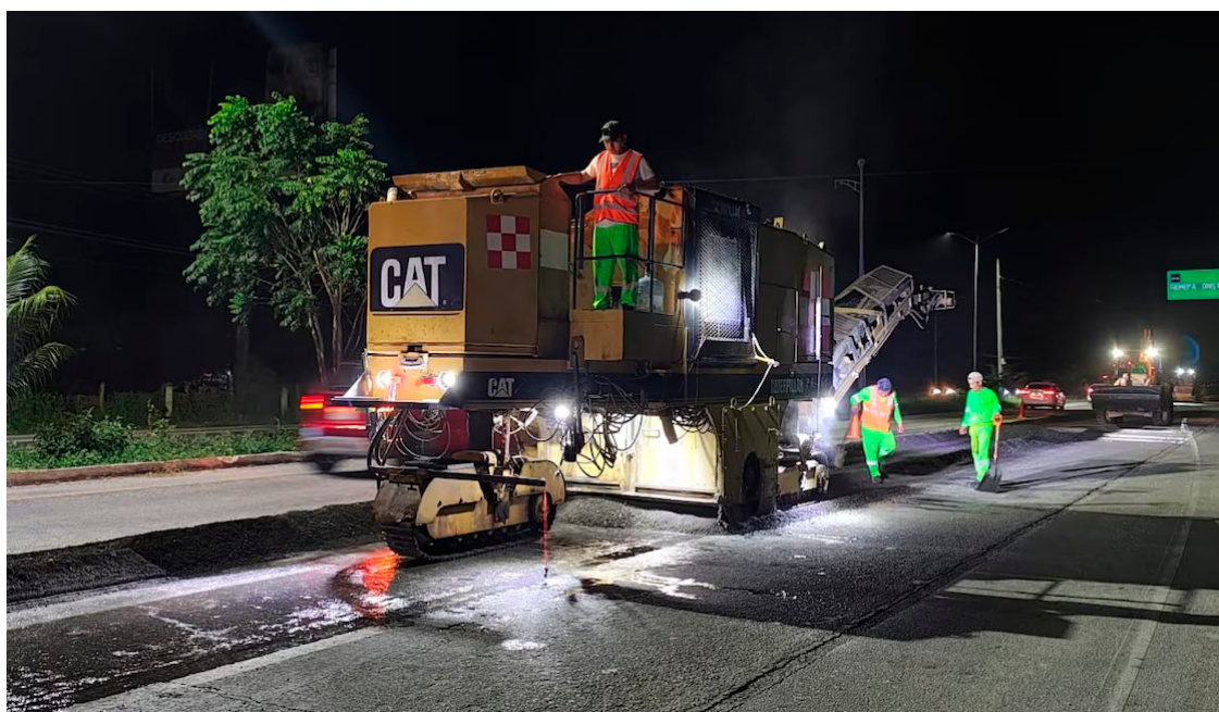
Rehabilitación de carreteras entró en su segunda etapa.
