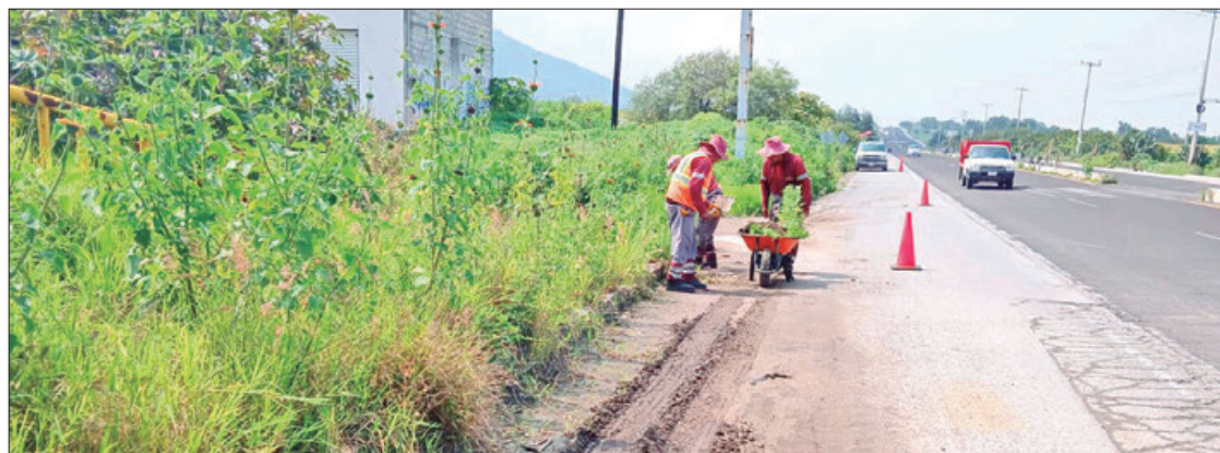
PROMESA. En las zonas que sean afectadas por las lluvias, se enviará maquinaria y personal para atender de manera inmediata las contingencias.
