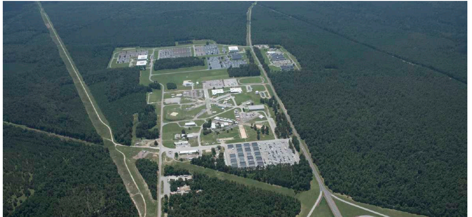
Imagen de la abandonada instalación nuclear del Río Savannah, en Carolina del Sur
