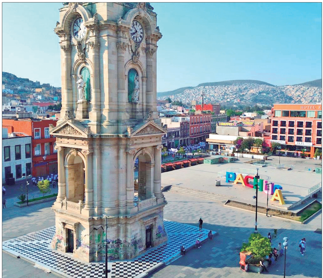
FECHAS. Los trabajos comenzarán el 15 de agosto y prevén un periodo de ejecución de 123 días naturales, por lo que terminarían el 15 de diciembre.
