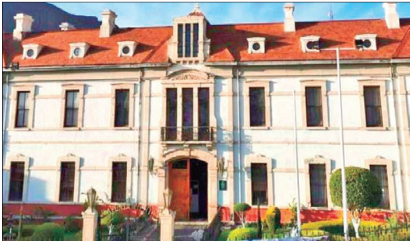
MARGEN. Agilizarán los procesos para evitar pérdidas de tiempo, tanto a la ciudadanía como a la administración pública.
