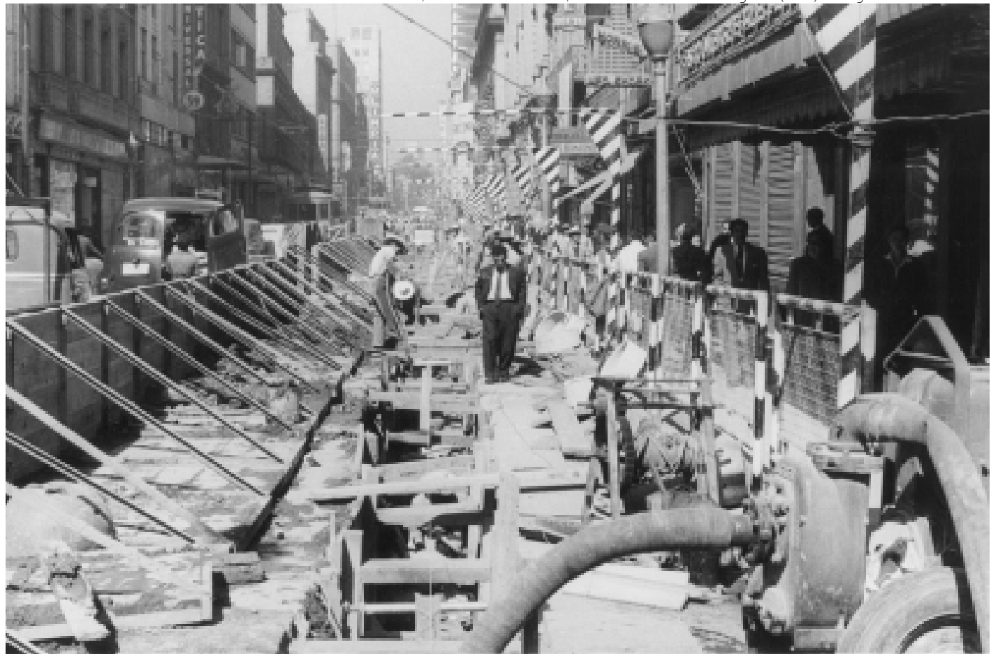
Cambio de drenaje calle 16 de septiembre, 1953.
