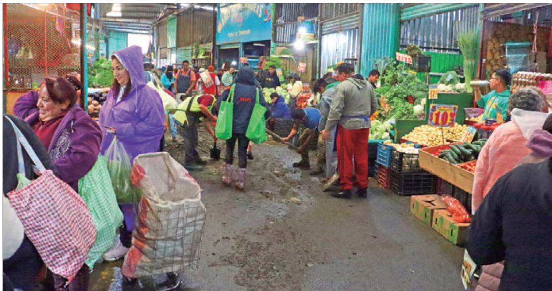
PROBLEMA. Los usuarios opinaron que las naves existentes no reciben mantenimiento continuo lo que es evidente el estado en el que se encuentra la infraestructura.
