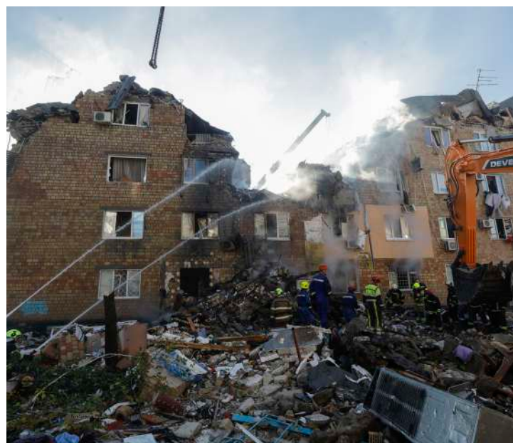
Edificio de viviendas destruido por el bombardeo ruso contra Kiev.
