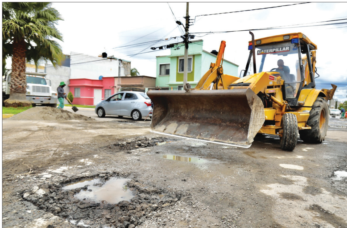
PROYECTO. Jorge Alberto Reyes dijo que también se inició la rehabilitación del bulevar Nuevo Hidalgo en el que se introducirá concreto hidráulico.
