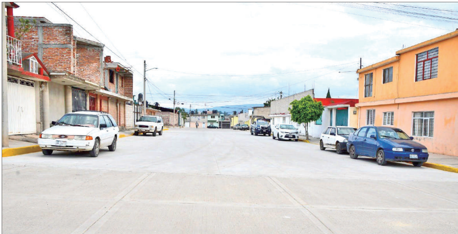
GIRA. La alcaldesa acudió a la colonia Santa Teresa, donde se construyeron guarniciones y banquetas de la calle Margaritas con monto cercano a 380 mil pesos.
