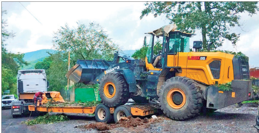
RETO. Debido a las dimensiones de las unidades y que el camino cuenta con curvas pronunciadas, se dificultó el avance.
