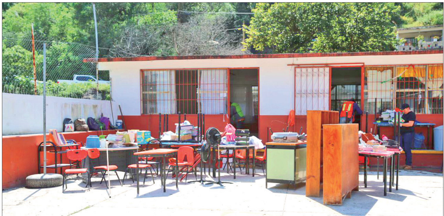
PENDIENTES. Continúan los trabajos de limpieza y desazolve para dar paso a la rehabilitación y en su caso reconstrucción de escuelas afectadas.
