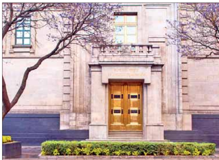
LINEAMIENTOS. Requirió la revisión del andamiaje en tema.
