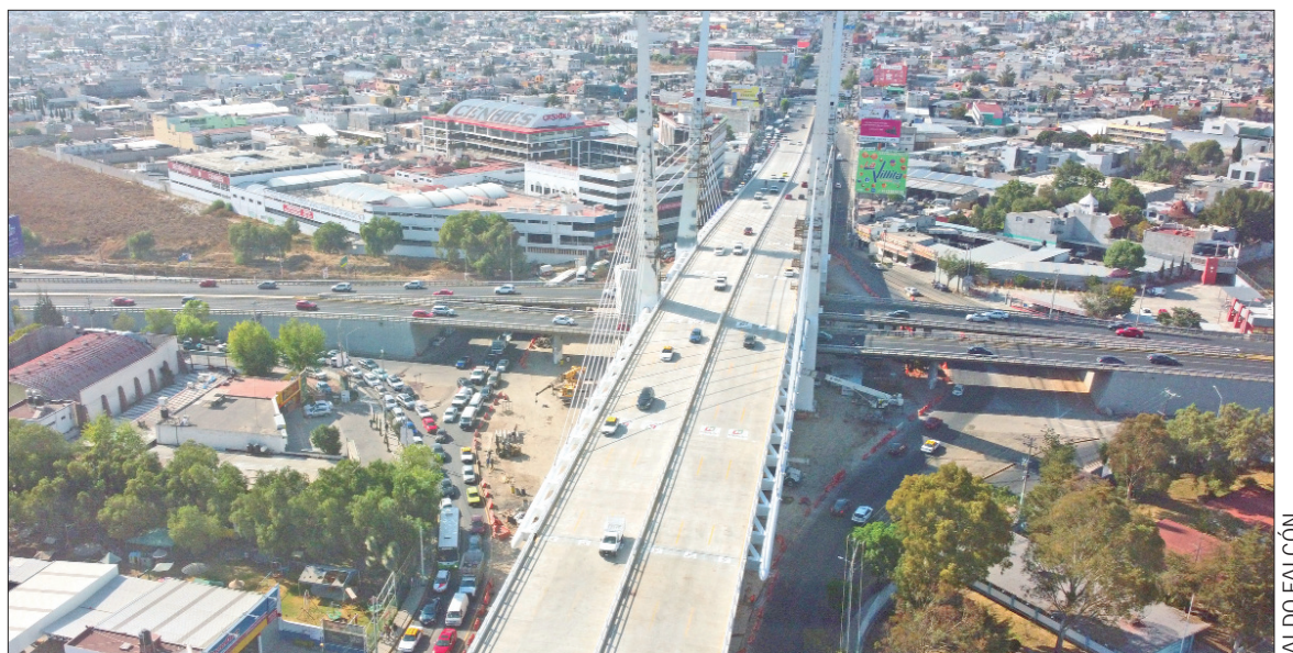
LO ESTRENARON. Por la tarde de este viernes, se abrió la circulación al paso superior del Puente Atirantado de la Súper Vía Colosio, en Pachuca, lo que permitirá desahogar un poco el tránsito de la zona.
