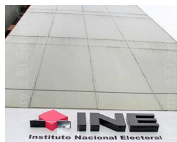
Van por el desmantelamiento.
