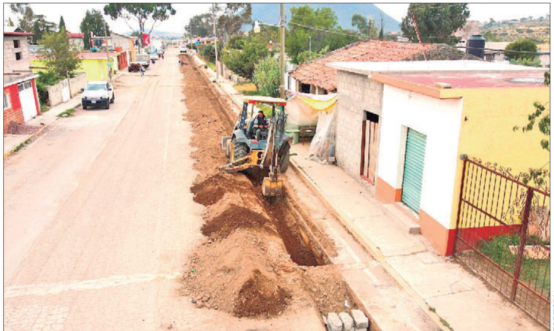
BENEFICIOS. Con esta obra vecinos del lugar tuvieron conexión para mejorar el servicio de distribución del líquido.
