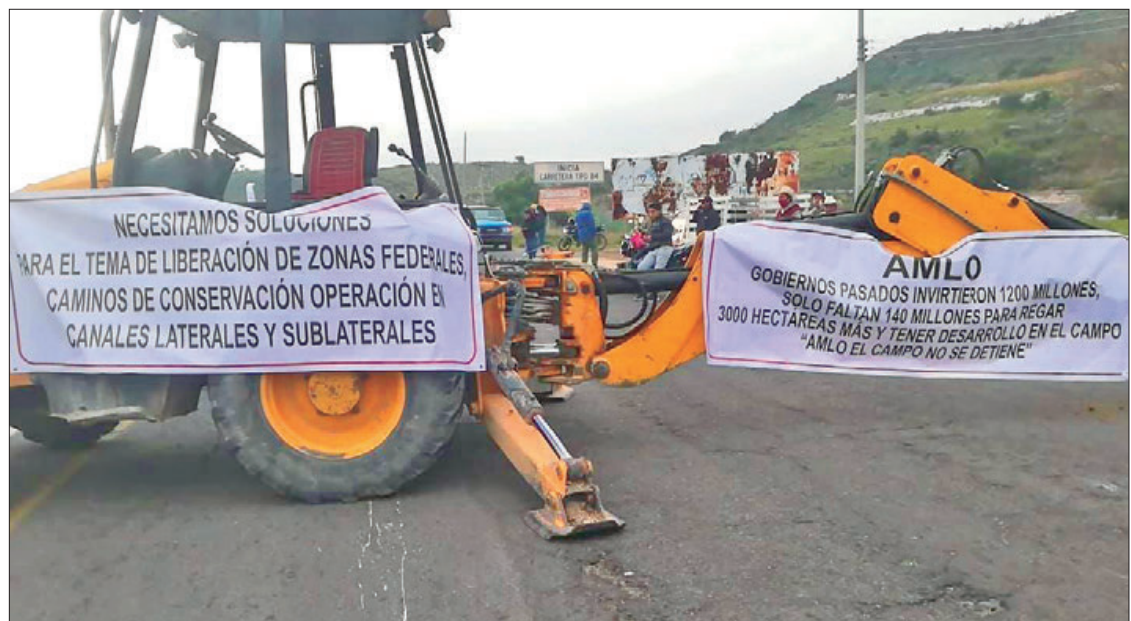
INCOMPLETO. En enero de 2015, el entonces director general de la Comisión Nacional del Agua, David Korenfeld Federman, anunció la construcción del canal de interconexión, cuya inversión sería de 80 millones de pesos, para la colocación de tubería que abarcaría 5.5 kilómetros.
