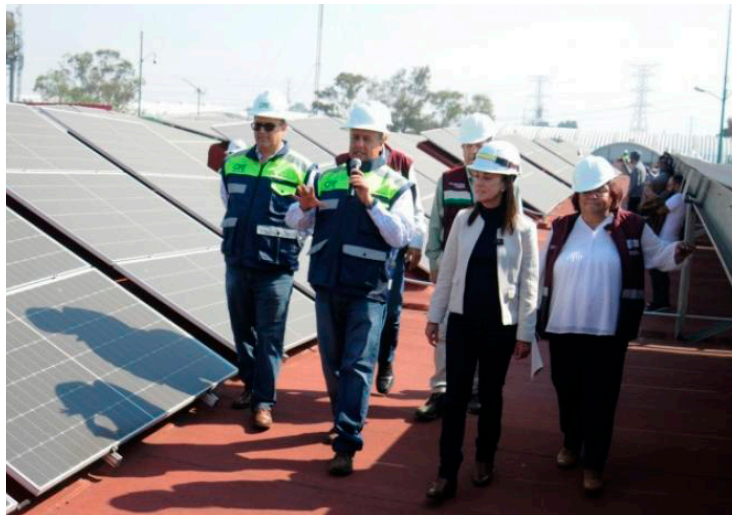
Claudia Sheinbaum encabezó el recorrido de supervisión de los avances de la primera fase de la obra.
