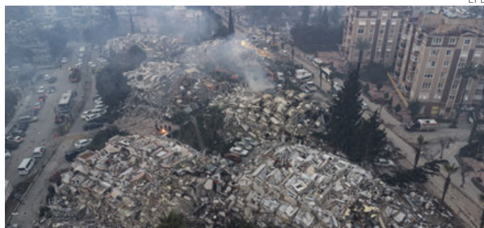
Vista parcial de la destrucción en la ciudad turca de Hatay.
