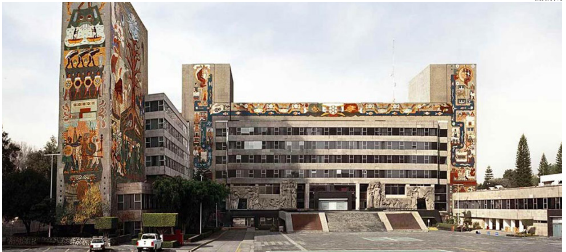
Hasta el momento, una tercera parte de los murales del Centro SCOP se han desmontado y puestos a resguardo.
