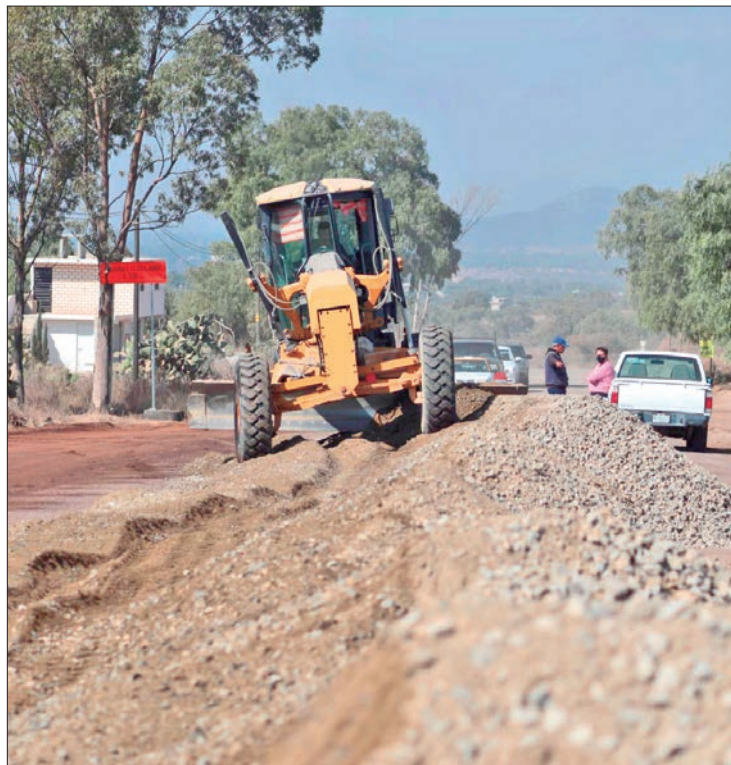
PROCESO. Los trabajos consisten en aplicar 23 mil 910 metros cuadrados de riego de sello, la construcción de 4 mil 166 metros cúbicos de base hidráulica y 20 mil 830 metros cuadrados de carpeta asfáltica.
