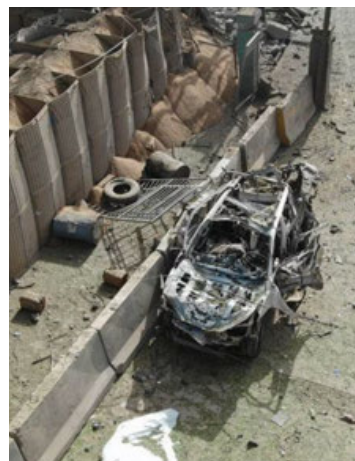
La explosión destruyó parte de los edificios aledaños.
