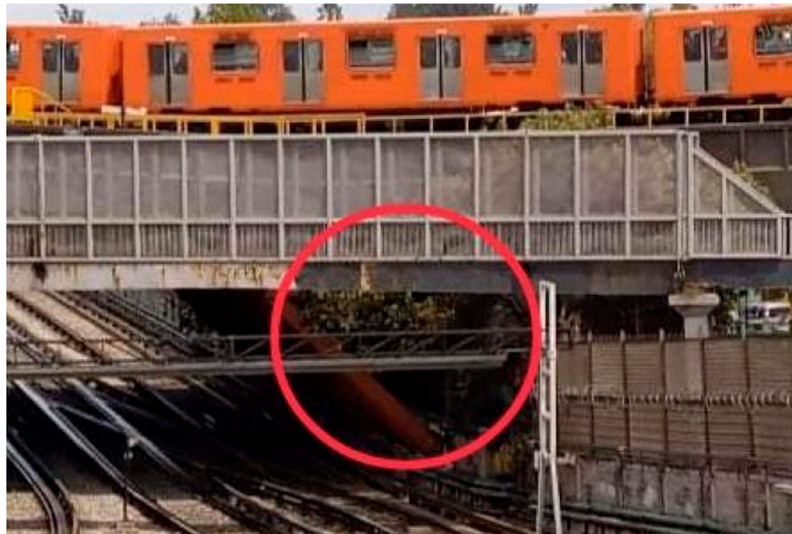
Se colocaron puntales sobre el cajón de la Línea 5, obstruyendo el paso sobre la vía 1 en la zona de maniobras de la línea amarilla.
