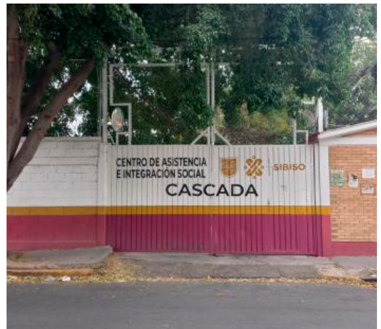
Albergue Cascada, para protección a mujeres vulnerables.
