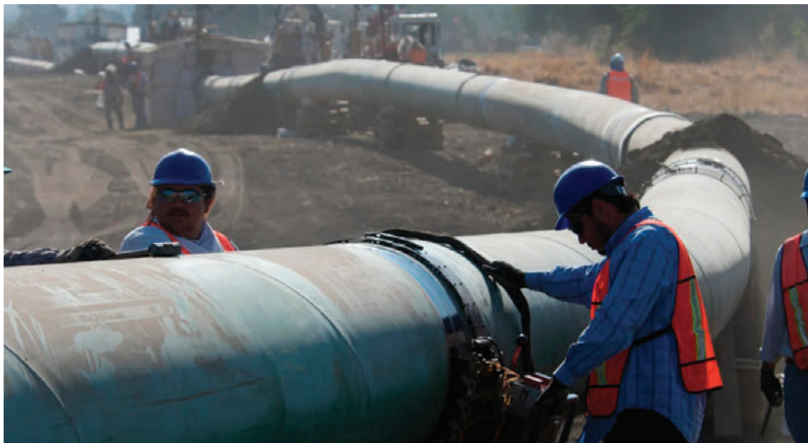
La red de gasoductos del país es insuficiente para cubrir la demanda.
