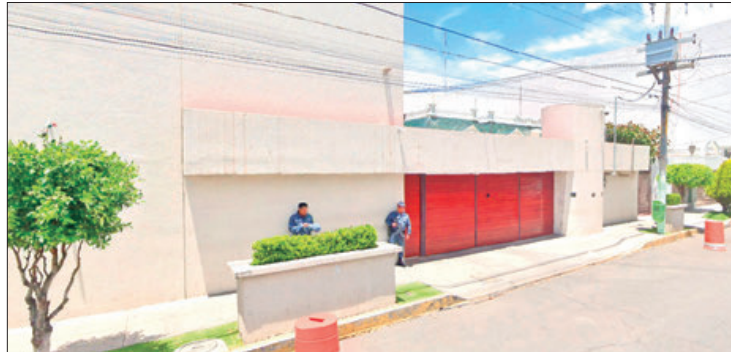
PASOS. Oficialía Mayor del Poder Ejecutivo solicitó la contratación de carga y descargas, para lo cual seleccionó a la empresa Ejecución de Servicios y Proyectos del Centro, S.A. de C.V. por un monto de 381 mil 607.75 pesos.
