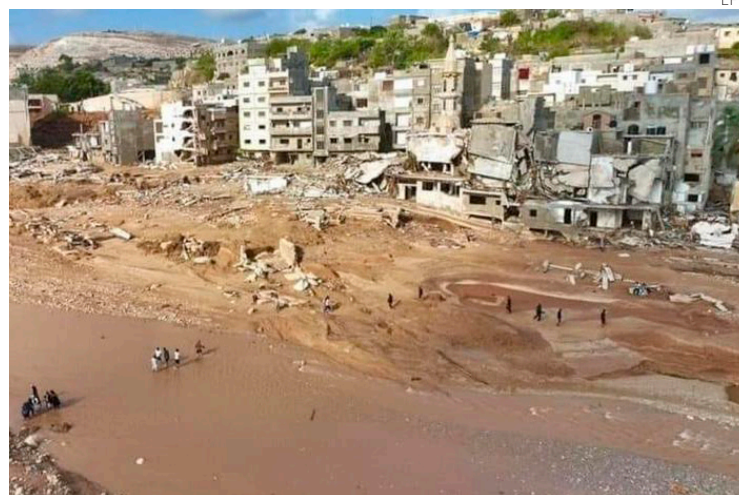
Viviendas destruidas en Derna por la rotura de dos represas.
