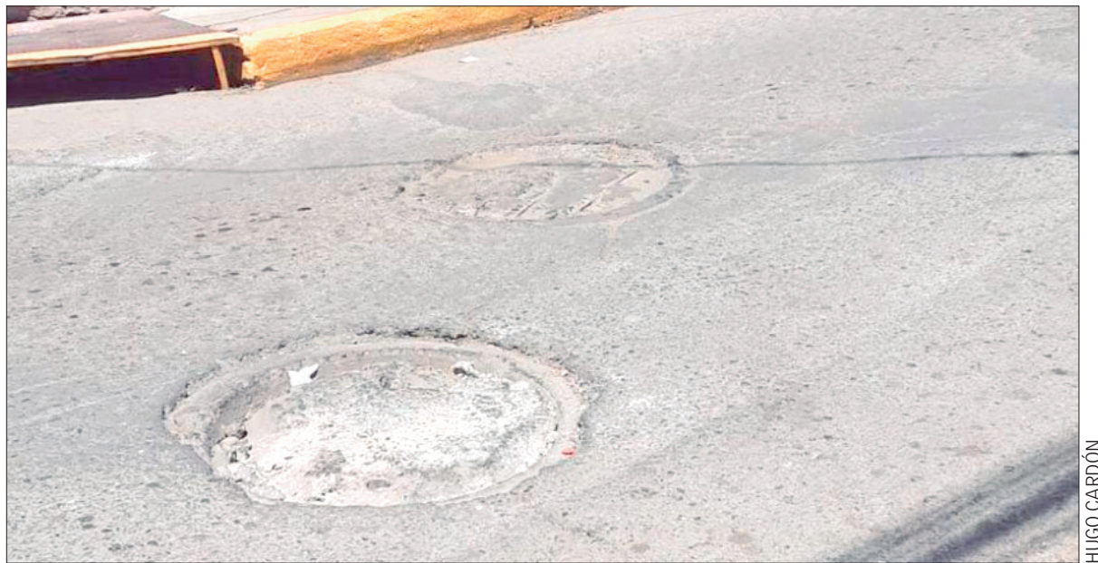
CONFIANZA. Las autoridades municipales y estatales ya ha tan tenido dos intervenciones para la rehabilitación de puentes considerados como patrimonio de Ixmiquilpan, como es el de la Otra Banda y el de Los Pinos, por lo que esperan que también éste cuente con el apoyo.
