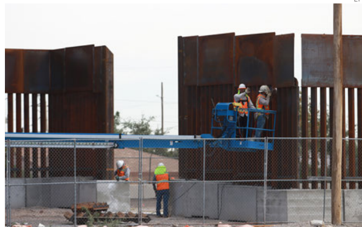
Trabajadores estadounidenses comienzan a reforzar el muro fronterizo en Ciudad Juárez.
