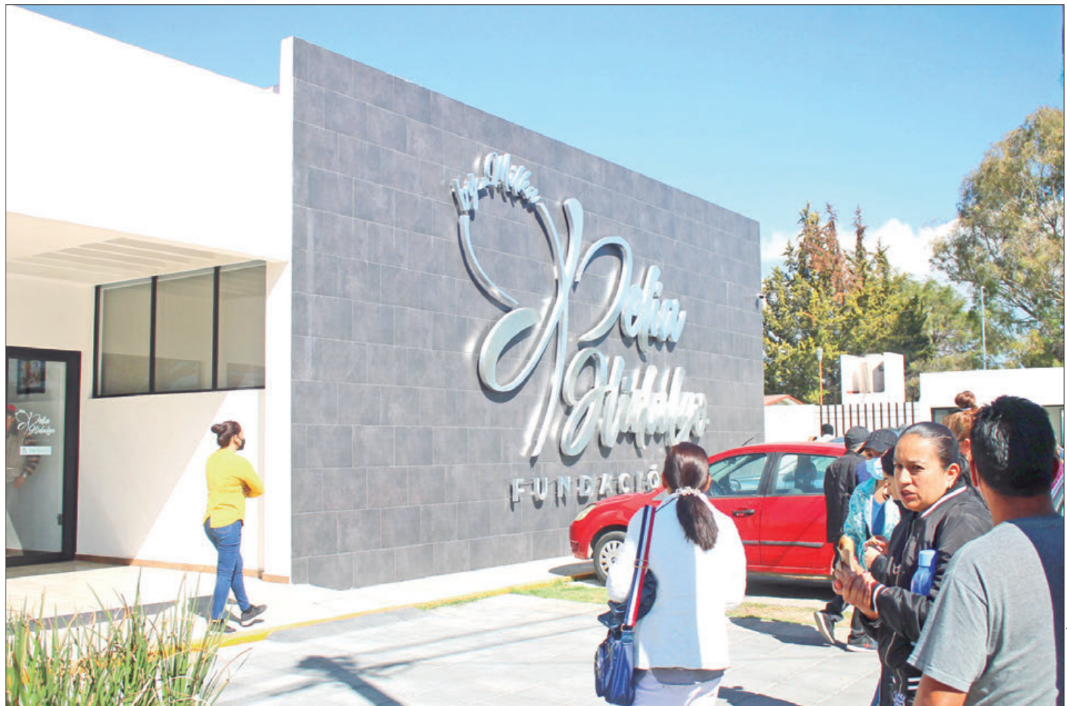
AHORA. Entró en vigor el procedimiento administrativo de reversión que inició la Oficialía Mayor en enero de este año al detectar que la edificación carecía de mobiliario y ofrecían banquetes ejecutivos.
