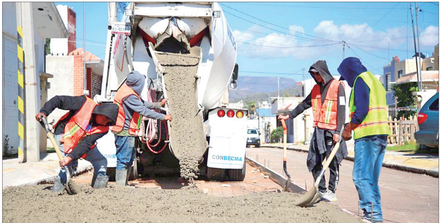
LLAMADO. Existe más de una veintena de calles que requieren atención inmediata para la restauración de las carpetas asfáltica.
