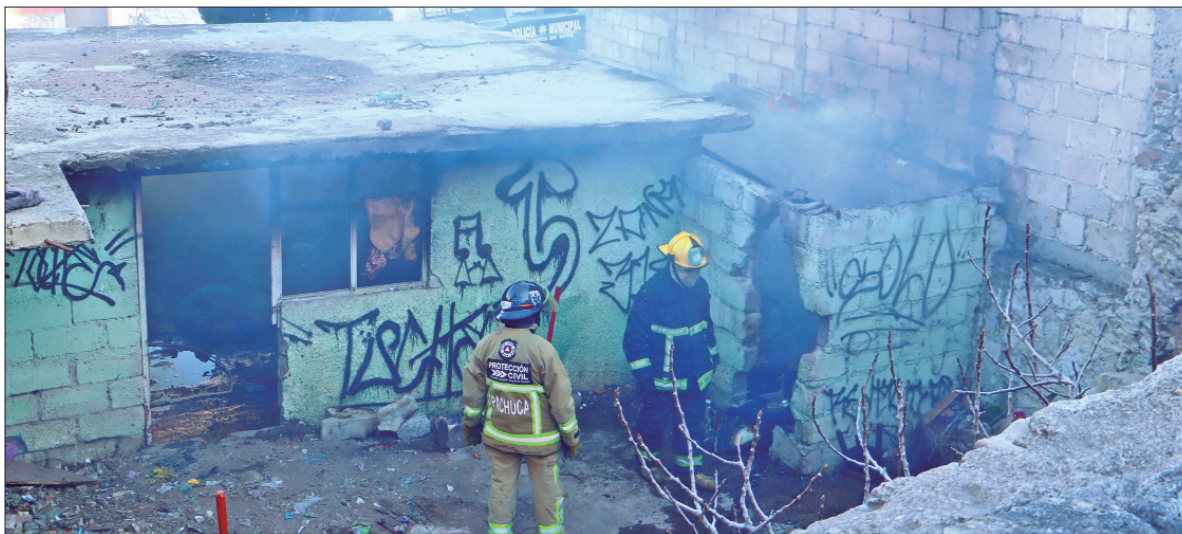
Incendio al interior de una vivienda de la colonia Cubitos en Pachuca; según personal de Bomberos del estado, mediante una llamada de emergencia avisaron sobre el incendio en la calle Alemán. Al arribar, los cuerpos de emergencia localizaron la conflagración, al interior de una vivienda abandonada; no se reportan personas lesionadas.
