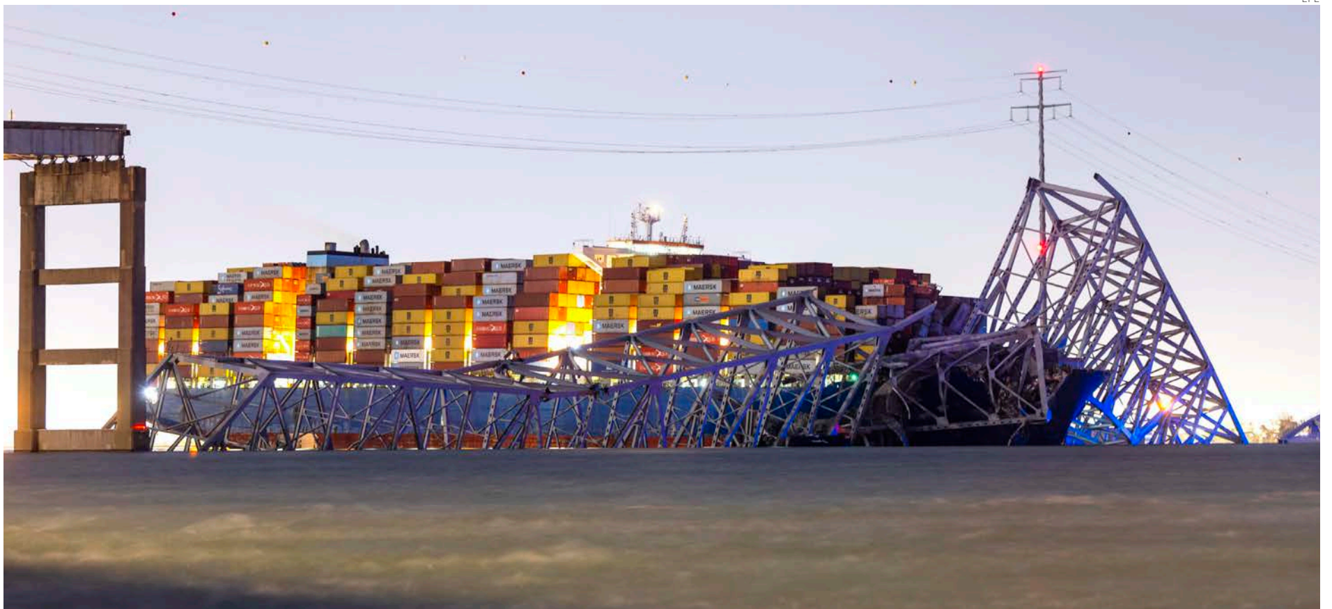
El buque quedó atrapado en una maraña de acero del puente colapsado.
