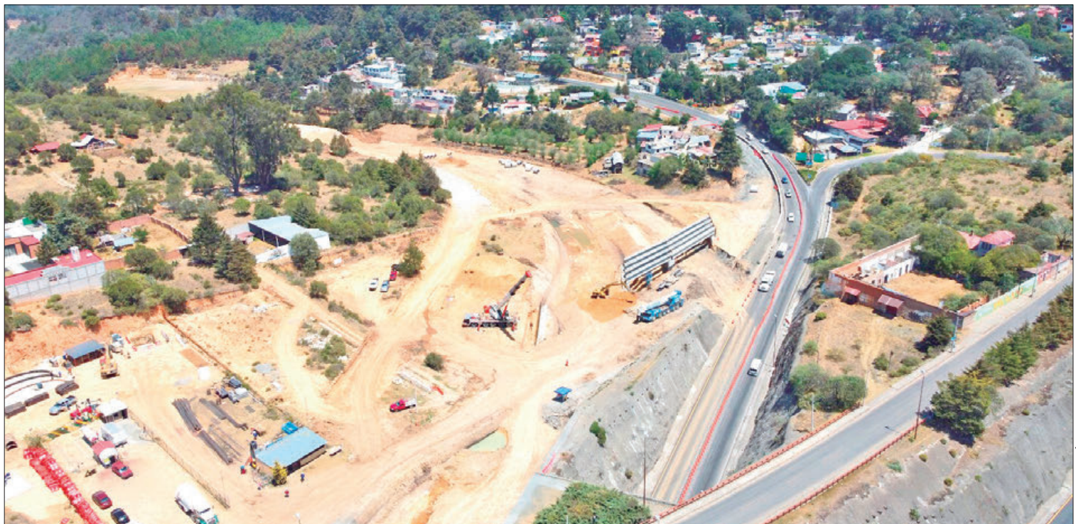
AVISO. En el cierre de la carretera federal Pachuca-Huejutla se alertará a la población con alarmas de sirena previas a la detonación.
