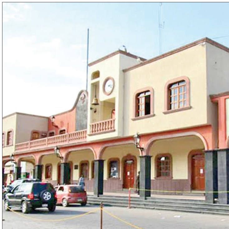
TIEMPO. Los trabajos iniciaron desde el pasado 18 de enero, por lo que ya suman dos meses y medio.
