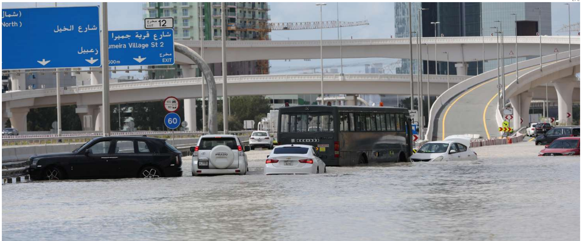
Una carretera inundada después de fuertes lluvias en Dubai, Emiratos Árabes Unidos.
