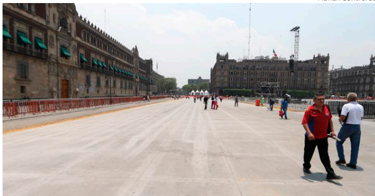
Nuevo pavimento en la plancha del Zócalo de la CDMX.
