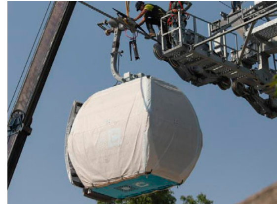
Pruebas del Cablebús de tramos Constituyentes y Panteón Dolores.
