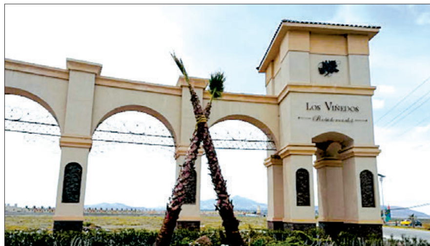
VISITA. Concluyeron en el recorrido que es necesario ejecutar programas de limpieza en líneas de abastecimiento de agua.
