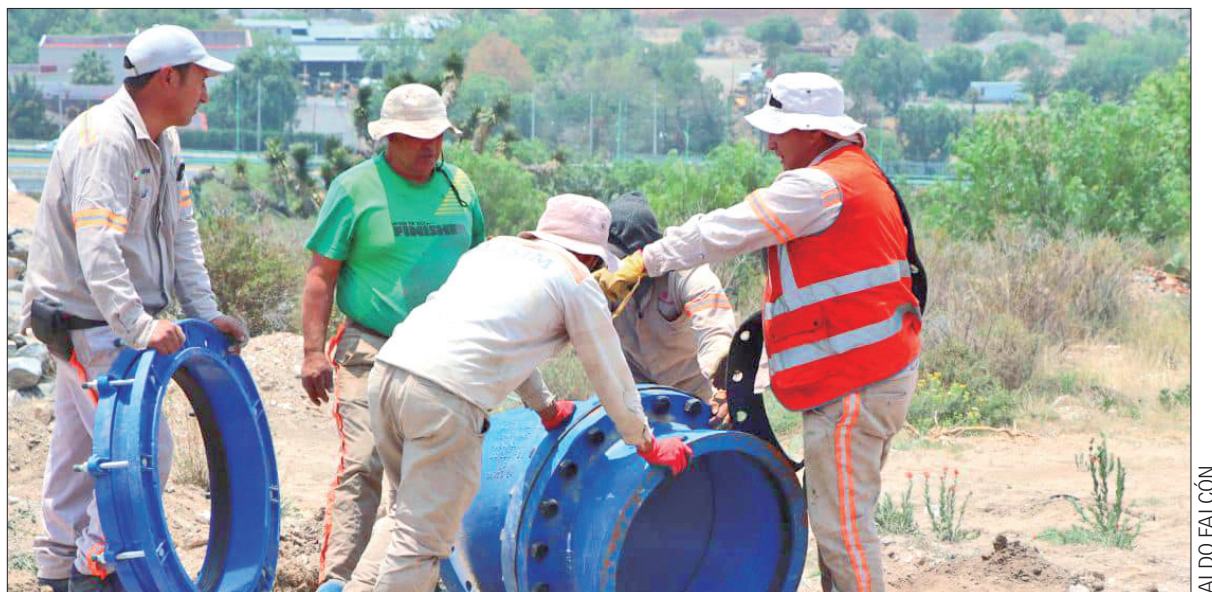
OBRA. Actualmente se trabaja en la sustitución de un ducto de 24 pulgadas entre el tanque de la colonia Abundio Martínez y el Salón Macros.
